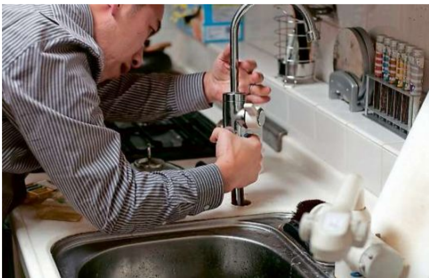
Ist die Reparatur eines undichten Wasserhahns «kleiner Unterhalt» oder schon «gewöhnlicher Unterhalt»? Zentrale Frage: Gefährdet der Mangel Mensch oder die Wohnung? Bild Pixabay
